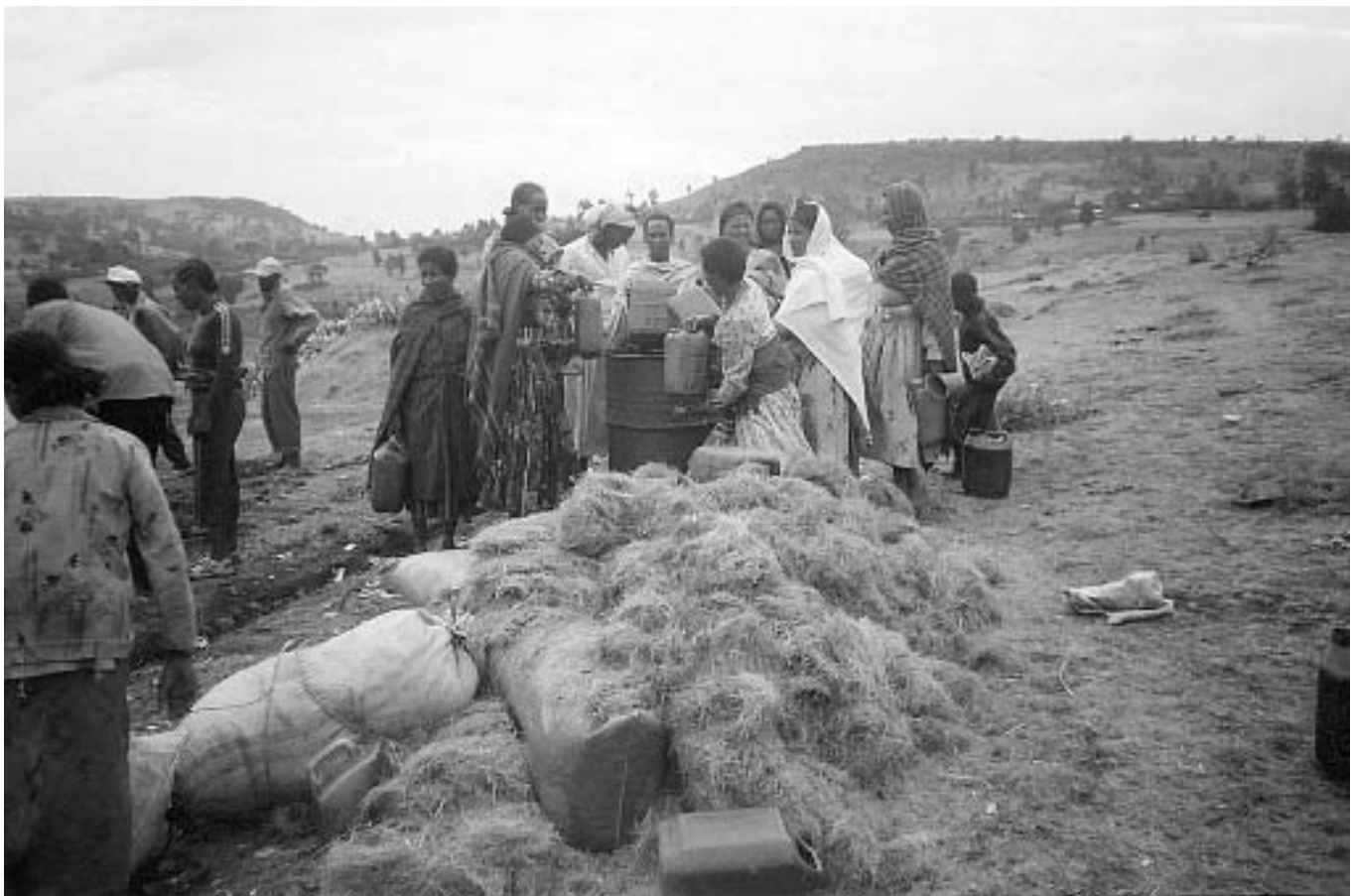
Aprile 2007. Donne Higgsu, con mariti e figli di ogni età all'opera nel preparare la "kikka", specie di cemento (fatto di paglia e terra) per le pareti della casa che ospiterà il mulino. Al momento viene già riempita l'impalcatura di pali fitti fitti. Il tetto di lamiera è completato.
